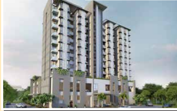
Athashri Hinjewadi, Pune
